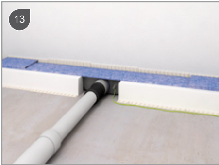
13 Afvoerbuis Ø50mm plaatsen / Connect Ø50mm waste pipe / Mettre le tuyau d'écoulement Ø50mm / Abwasserrohr DN 50 aufstecken
